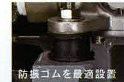
防振ゴムを最適設置
